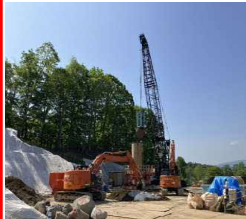
岩塊撤去状況
