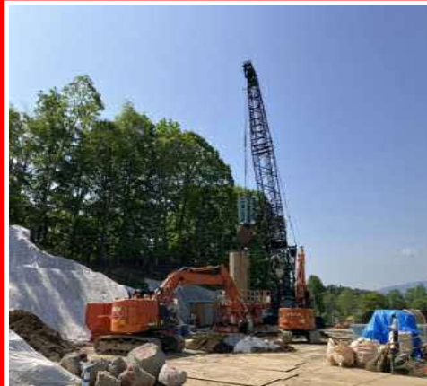
岩塊撤去状況
