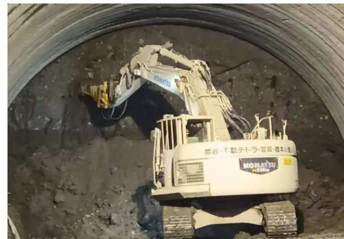
NATM掘削状況
