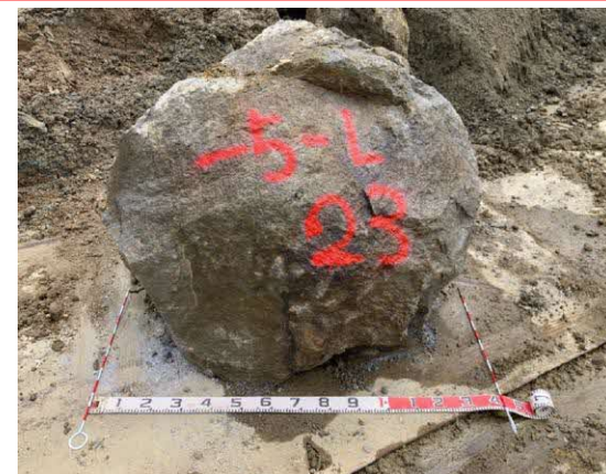
撤去された岩塊
