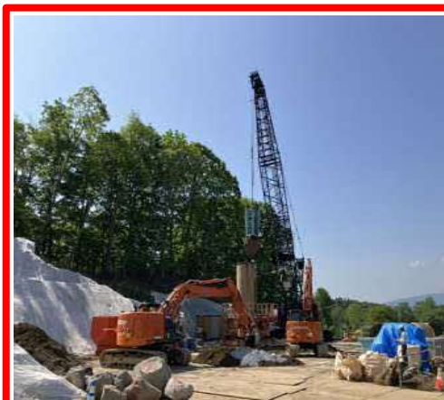
岩塊撤去状況
