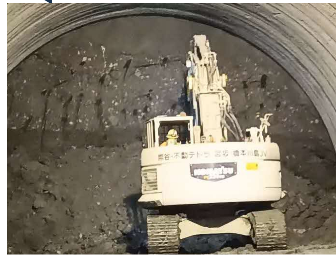
NATM掘削状況
