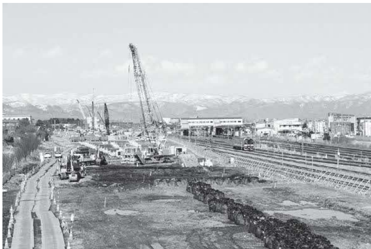
北海道新幹線延伸工事の様子
