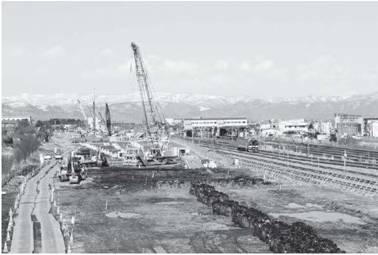
北海道新幹線延伸工事の様子
