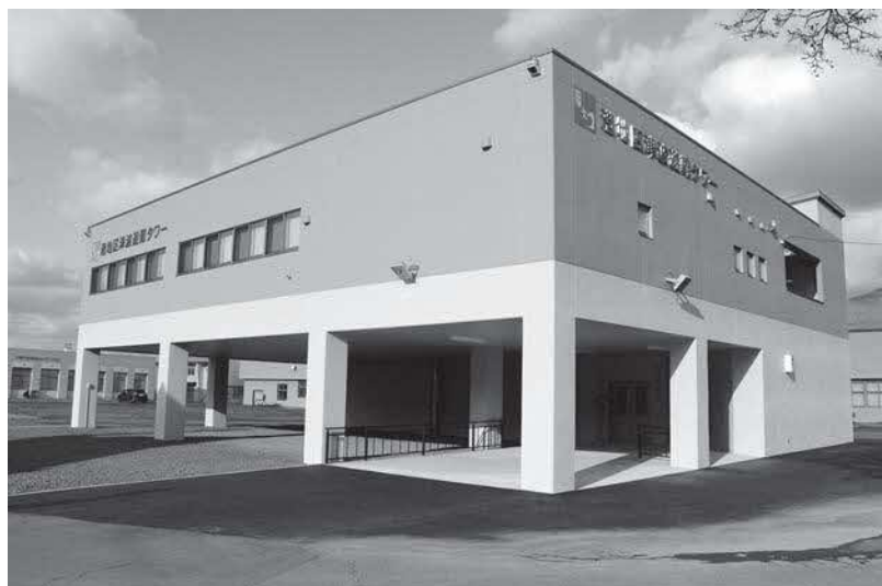
2.3mの津波を想定した蘭越町の津波避難タワー
