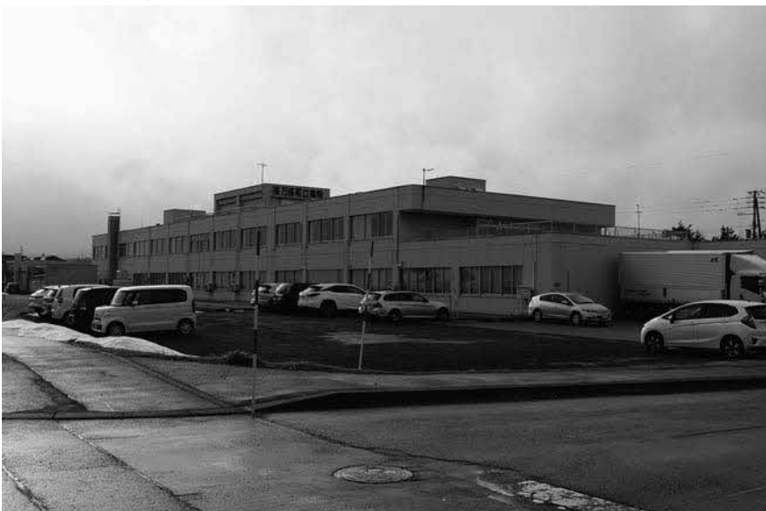
移転建替計画予定の町立病院
