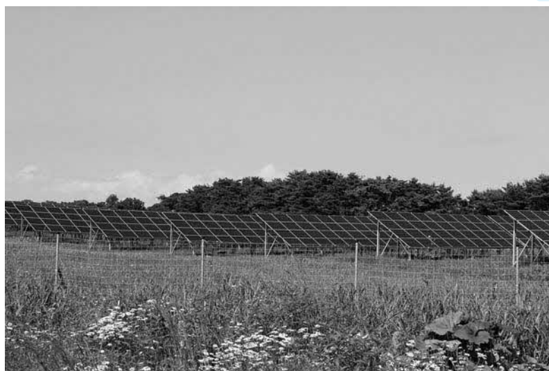
設置が増えて来ている太陽光パネル
