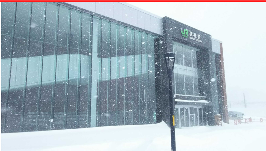
苗穂駅 北口(エレベータ、エスカレーター、階段施設)
