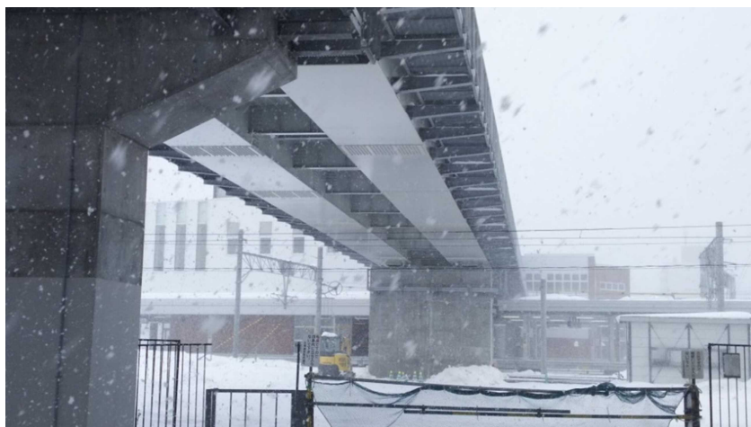
札幌市 苗穂駅 自由通路 ※線路上を通過 通路高さは約8m
