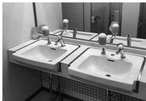
補助金で改修したガソリンスタンドのトイレ
