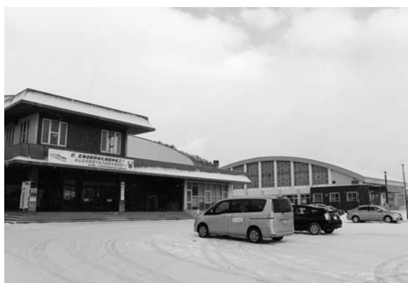
老朽化が進む公共施設
