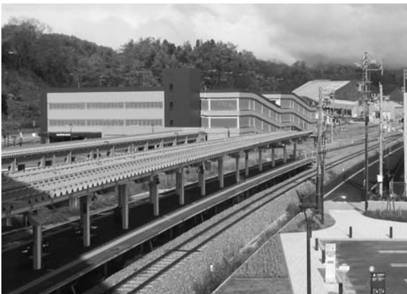
収容数409台の立体駐車場
