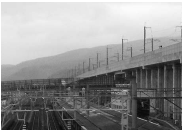
跨線橋の上を行く新幹線高架橋
