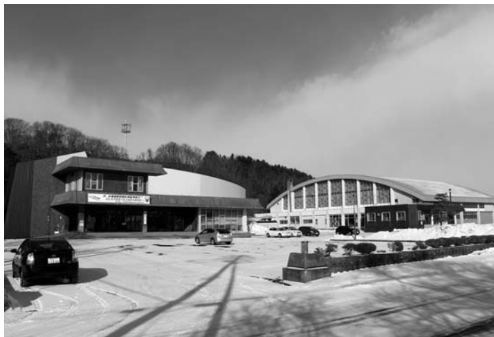
老朽化が進む公共施設
