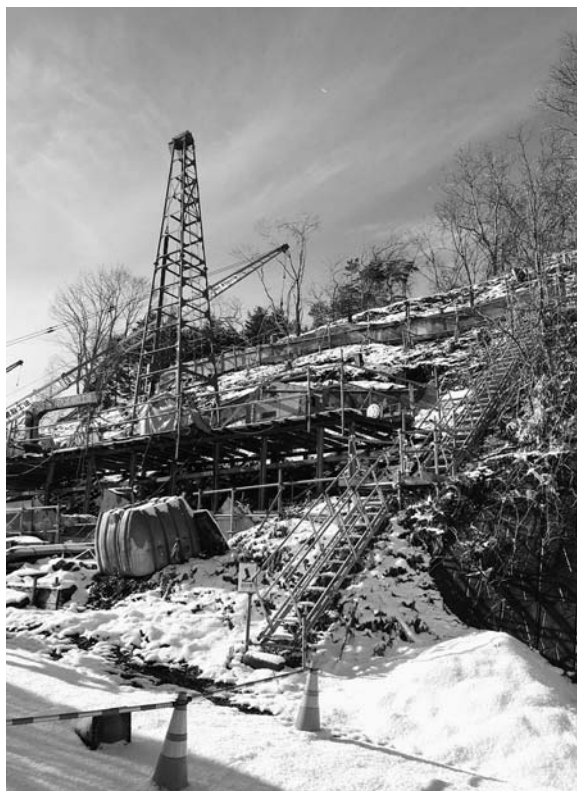
高砂地区のり面对策工事
