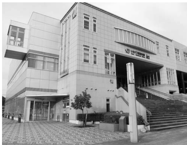
岩手広域交流センター「プラザあい」
