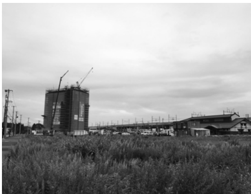
駅前に建設中のビジネスホテル
