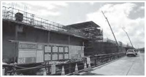
←町内工事の様子
