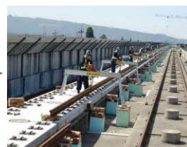
F : レール敷設
