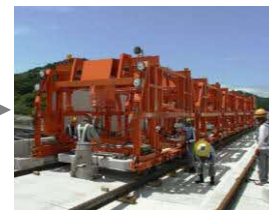
D : 軌道スラブ敷設
