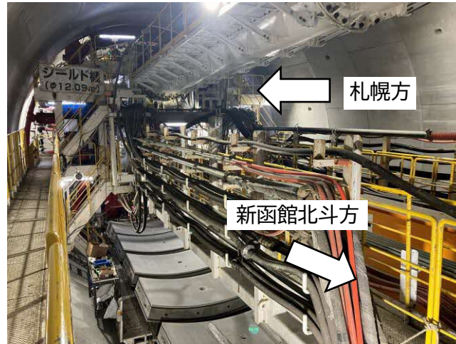
札幌方掘進の様子
