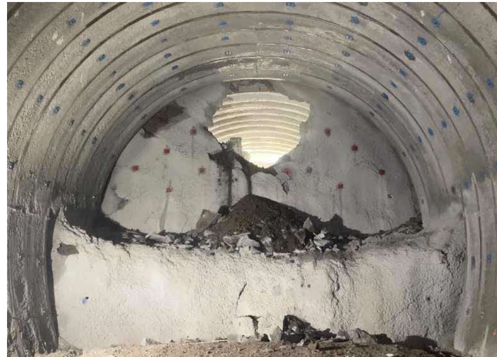
掘削完了地点の状況
