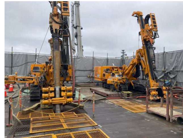
凍結管埋設の様子
