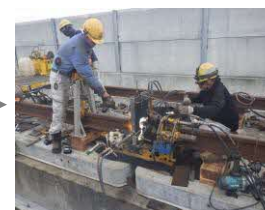
G : 二次溶接
