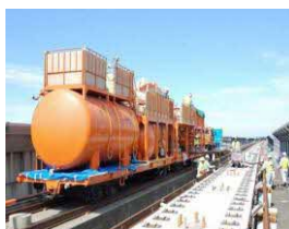
E : CAモルタル注入
