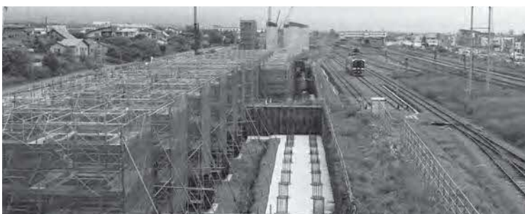
新幹線工事の様子
