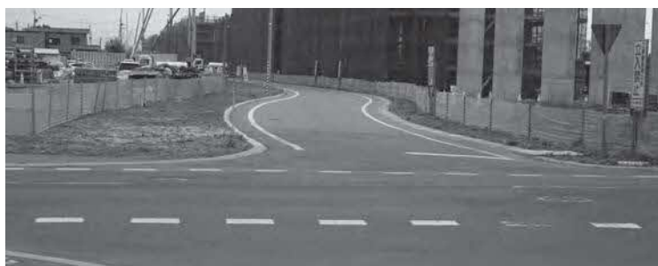
スライド条項を適用し整備した町道長万部中の沢線
