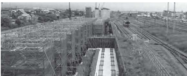
新幹線工事の様子
