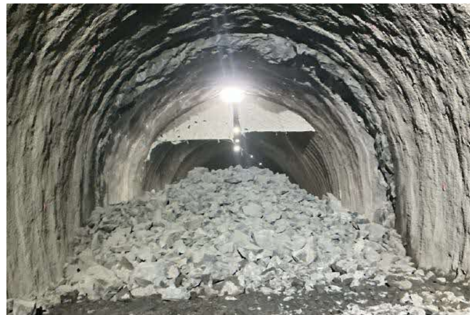
掘削完了地点の状況
