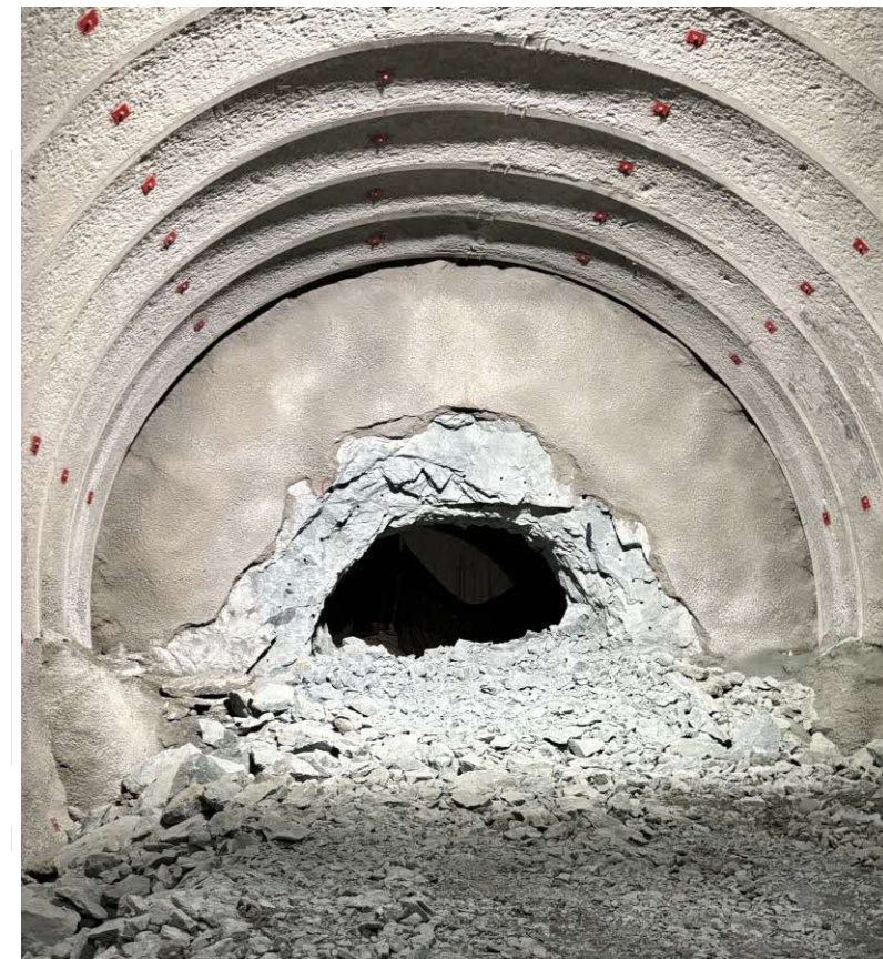
掘削完了地点の状況
