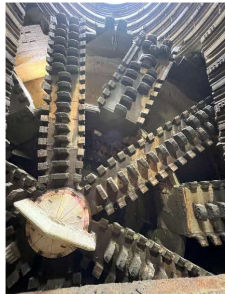
ビット交換作業完了
