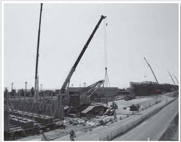
工事現場（大町）
