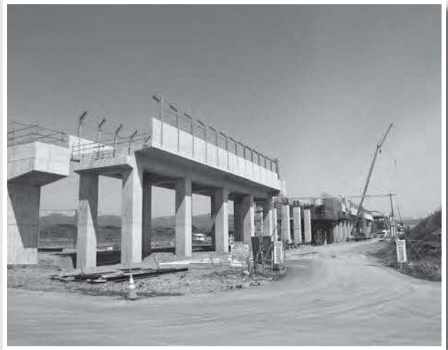
工事現場（栄原）
