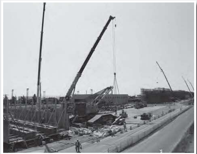
工事現場（大町）
