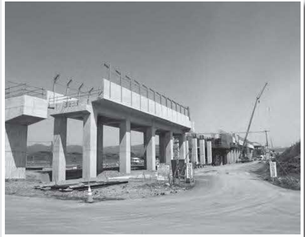
工事現場（栄原）
